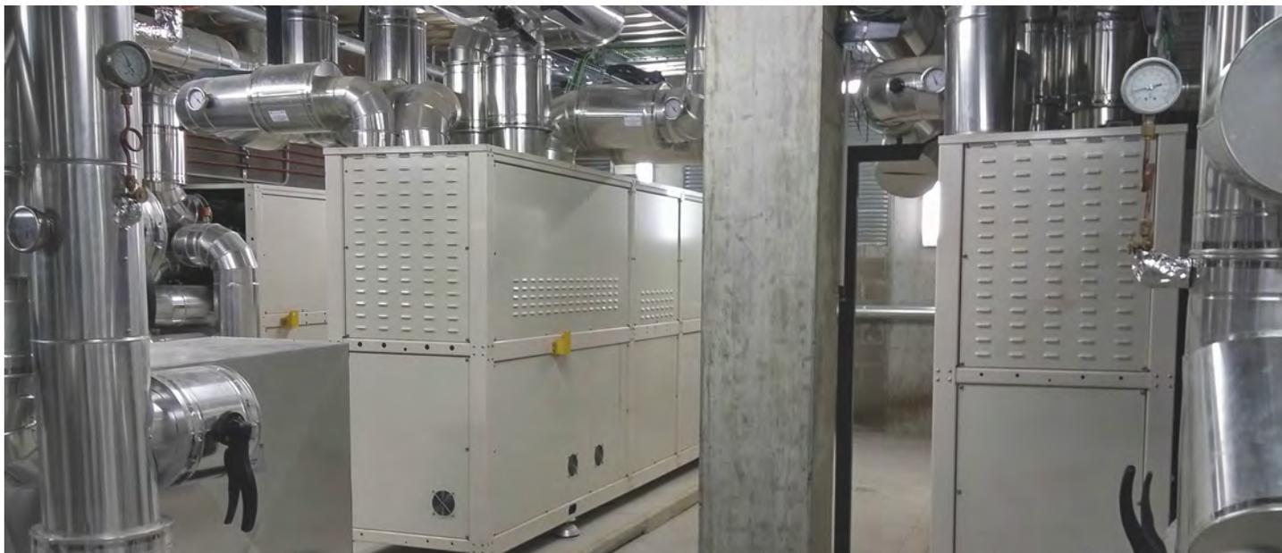
La centrale termofrigorifera è composta da due unità in pompa di calore reversibili (nell'immagine) e da un gruppo frigorifero condensato ad acqua, più una pompa di calore dedicata alla produzione dell'ACS (Clivet).
