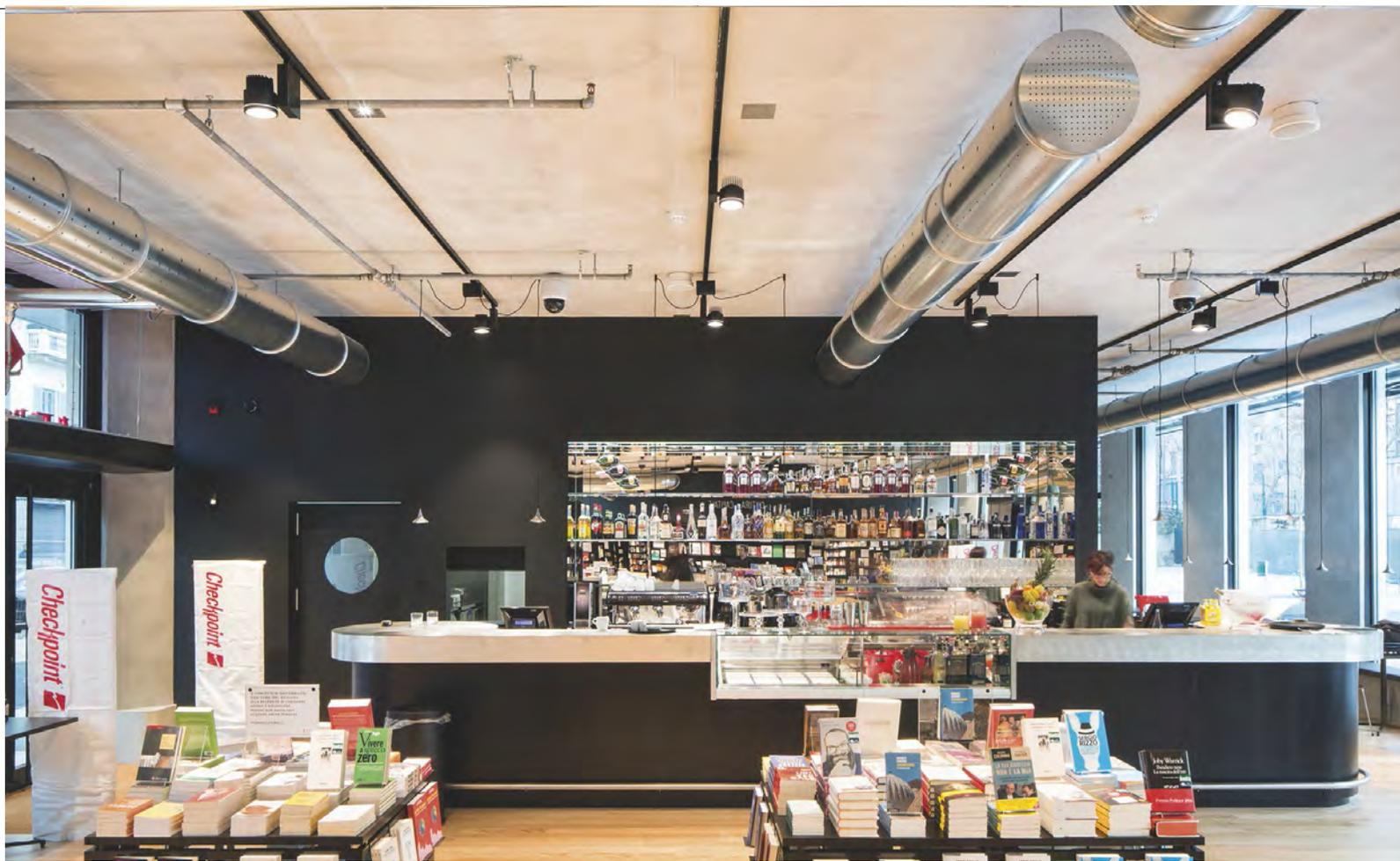
Negli spazi commerciali al piano terreno di entrambi gli edifici, l'impianto a tutt'aria prevede la distribuzione mediante canalizzazioni metalliche microforate dalla forma cilindrica (Filippo Romano).
